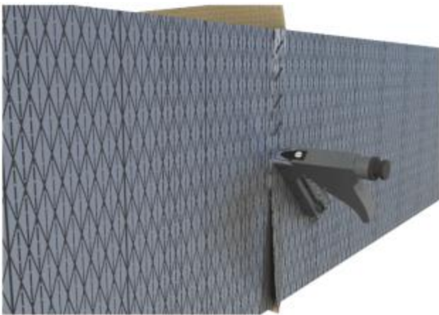
Agrafer la languette de la feuillure mâle
