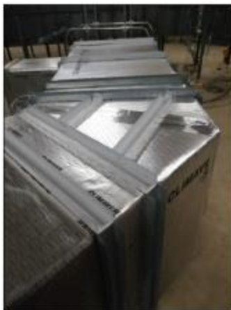
Figure 30 – Mise en place de traverses pour les renforts (exemple côté extérieur)
