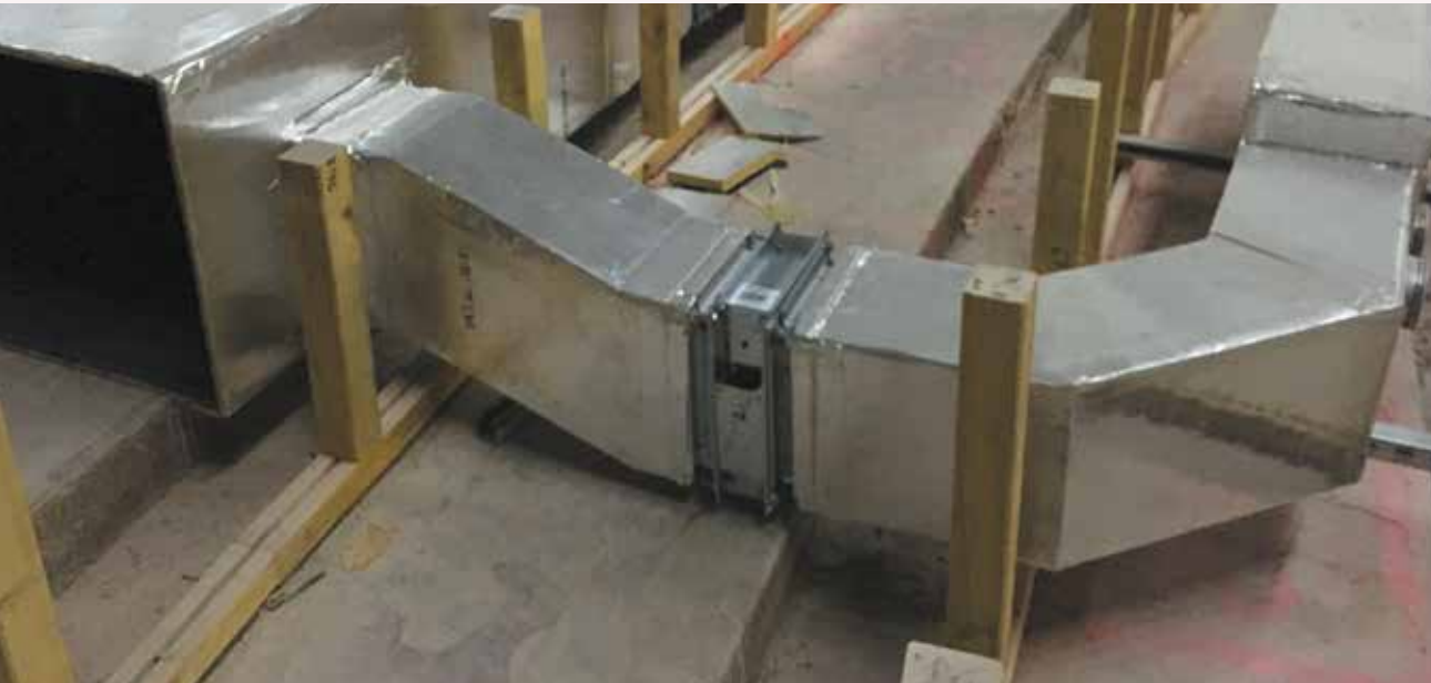
Mise en œuvre d'un registre d'équilibrage avec l'utilisation d'un profilé h.
