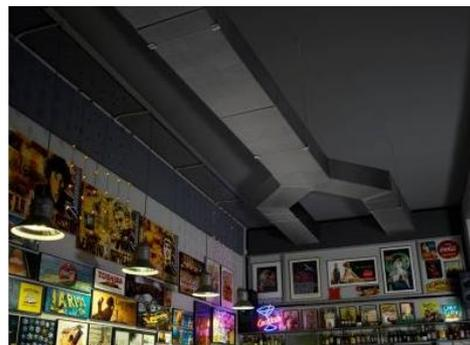
La pose sera conforme à l'Avis Technique du système n° 14.5/20-2304\_V1. Les panneaux en laine de verre seront conformes à la norme NF EN 14303 et comporteront un marquage CE.
